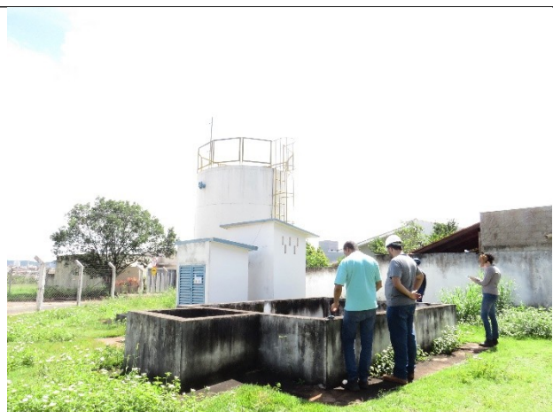
Autor: AMAE Descrição: RAP, quadro de comando e booster
