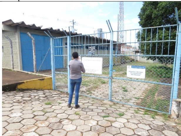
Autor: AMAE Descrição: Placas de identificação no booster Abóbora.
